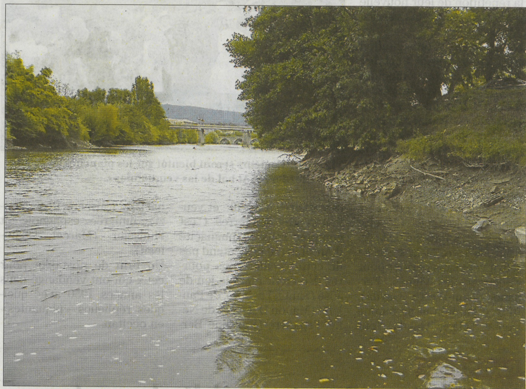
► 500 km de berges ont été restaurées en dix ans par le syndicat.
